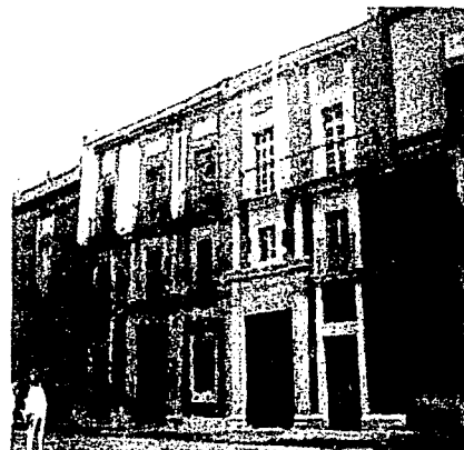
Restauración en la Calle de Guatemala.
