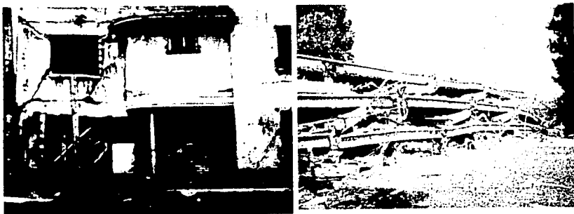
Figura 1 5 Daños provocados por sismo
