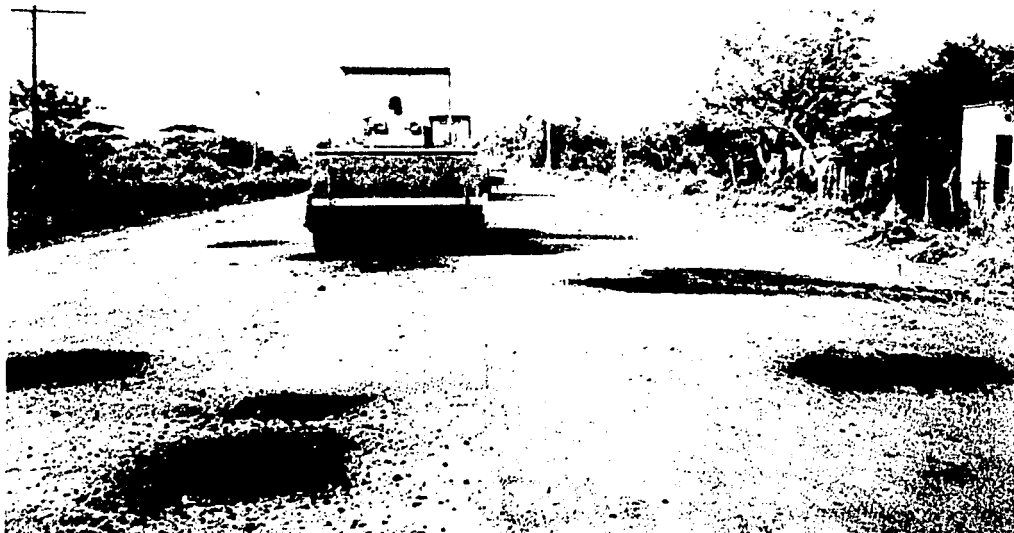
COMPACTACION DE CAJAS.
