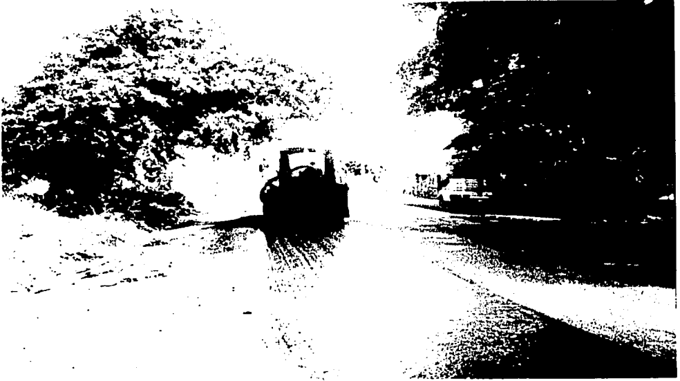
APLICACIÓN DE RIEGO DE LIGA PARA SELLO.
