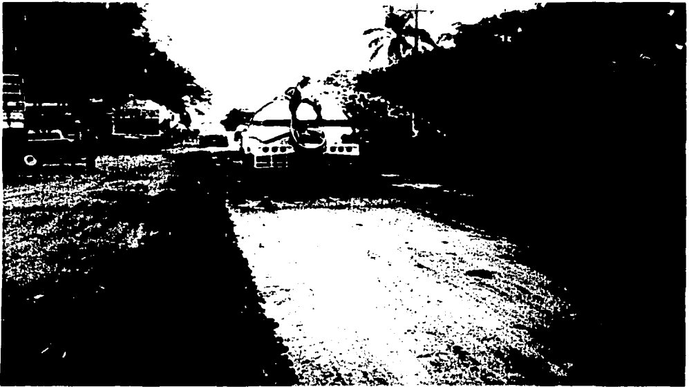
PIPA DE AGUA HUMEDECIENDO SUPERFICIE DESCUBIERTA, PRODUCTO DE LA ESCARIFICACIÓN, PARA RECIBIR SU COMPACTACION.
