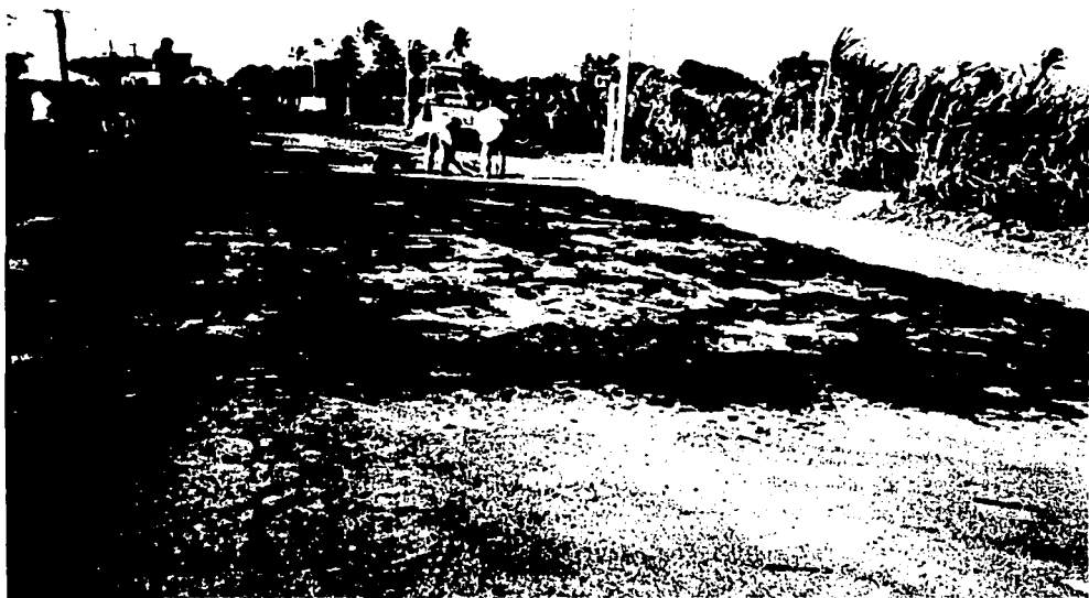
PERSONAL LIMPIANDO, MOJANDO E IMPREGNANDO SUPERFICIE DESCUBIERTA, PRODUCTO DE LA ESCARIFICACIÓN.
