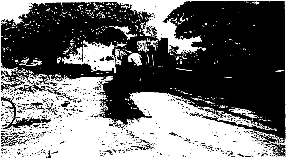
RIEGO DE LIGA SOBRE SUPERFICIE PREVIAMENTE BARRIDA.
