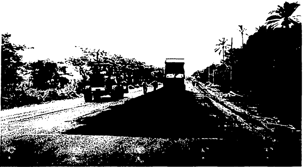
ACARREO DE MEZCLA ASFÁLTICA EN FRIO Y DEPOSITADA SOBRE EL CAMINO PARA LA FORMACIÓN DE LA CARPETA ASFÁLTICA.
