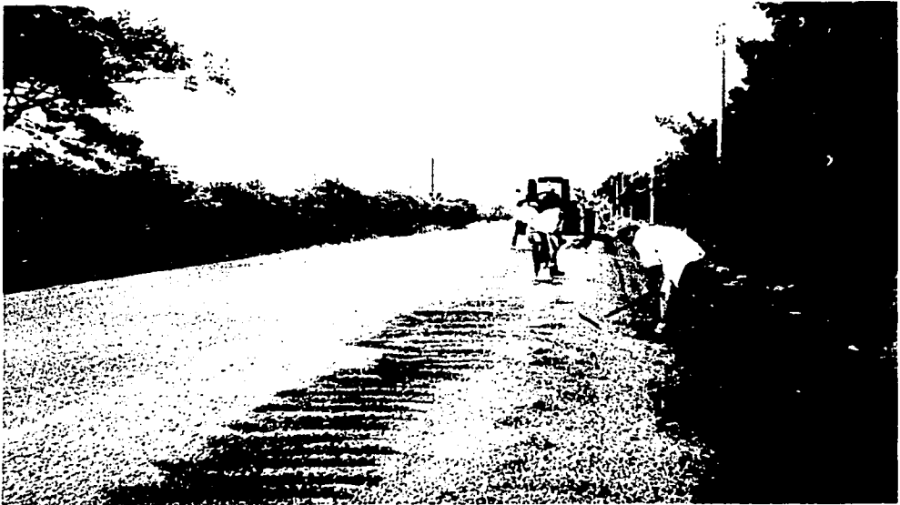
APLICACIÓN DEL MATERIAL DE SELLO SOBRE LOS HOMBROS DEL CAMINO.
