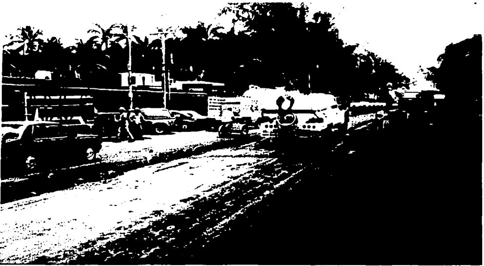
PIPA DE AGUA HUMEDECIENDO SUPERFICIE DESCUBIERTA, PRODUCTO DE LA ESCARIFICACIÓN, PARA RECIBIR SU COMPACTACION.
