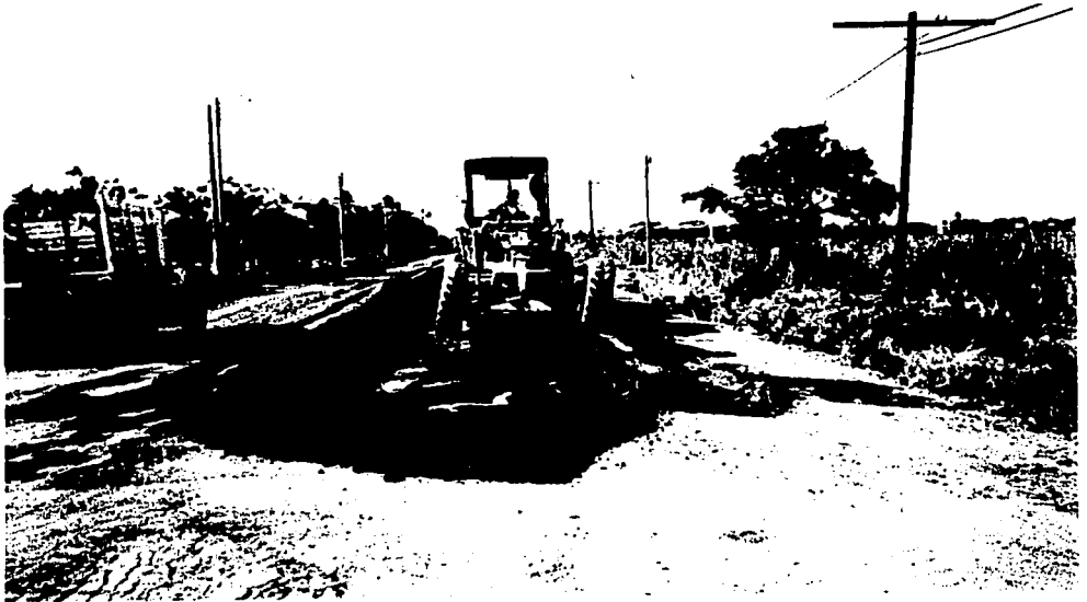
MOTOCONFORMADORA ESCARIFICANDO SUPERFICIE.
