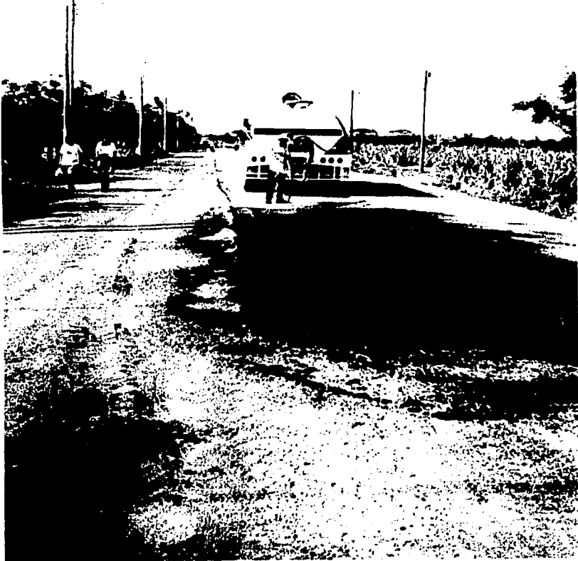
PIPA DE AGUA HUMEDECIENDO SUPERFICIE DESCUBIERTA PRODUCTO DE LA ESCARIFICACIÓN.
