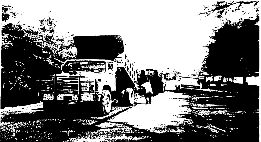
RIEGO DE SELLO SOBRE CARPETA ASFÁLTICA (SUPERFICIE DE RODAMIENTO) .
