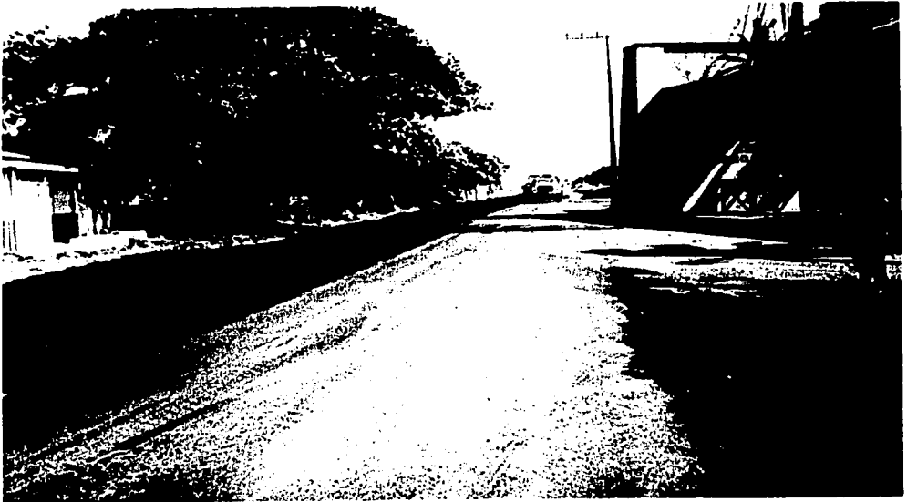
RIEGO DE LIGA SOBRE SUPERFICIE PREVIAMENTE BARRIDA.
