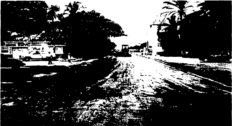
MOTOCONFORMADORA ESCARIFICANDO SUPERFICIE DE RODAMIENTO PARA REALIZAR LA RECONSTRUCCIÓN DE LA BASE FRENTE AL INGENIO SAN PEDRO.
