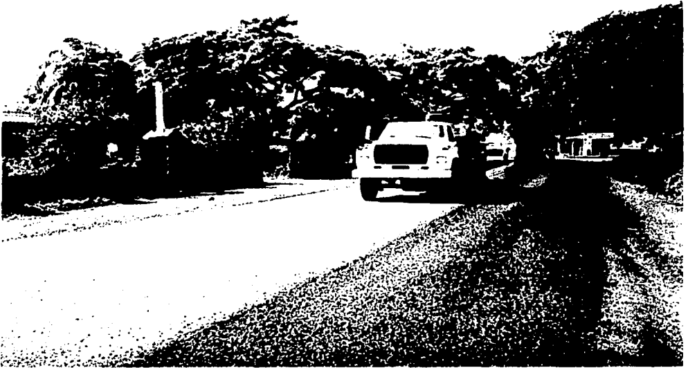
RIEGO DE SELLO SOBRE CARPETA ASFÁLTICA (SUPERFICIE DE RODAMIENTO) .
