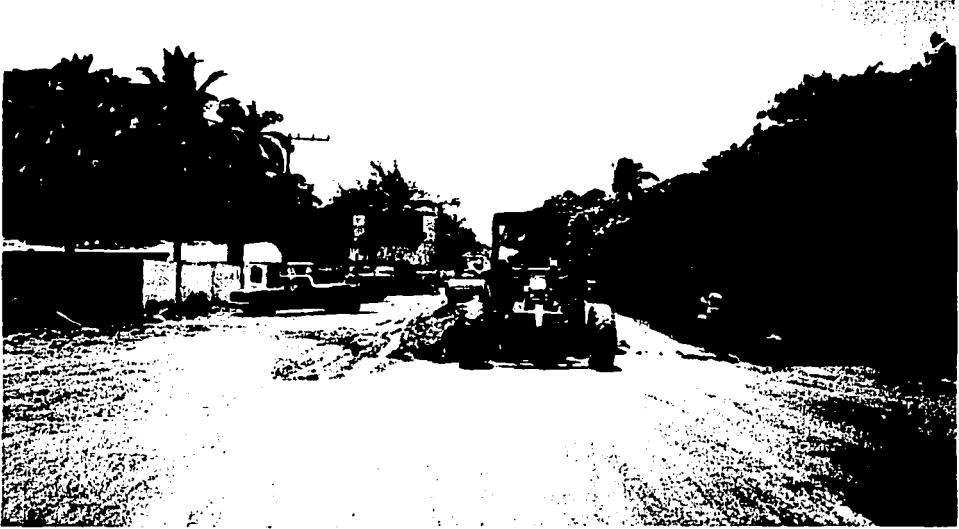
RECONSTRUCCIÓN DE BASE HIDRÁULICA FRENTE AL INGENIO SAN PEDRO.
