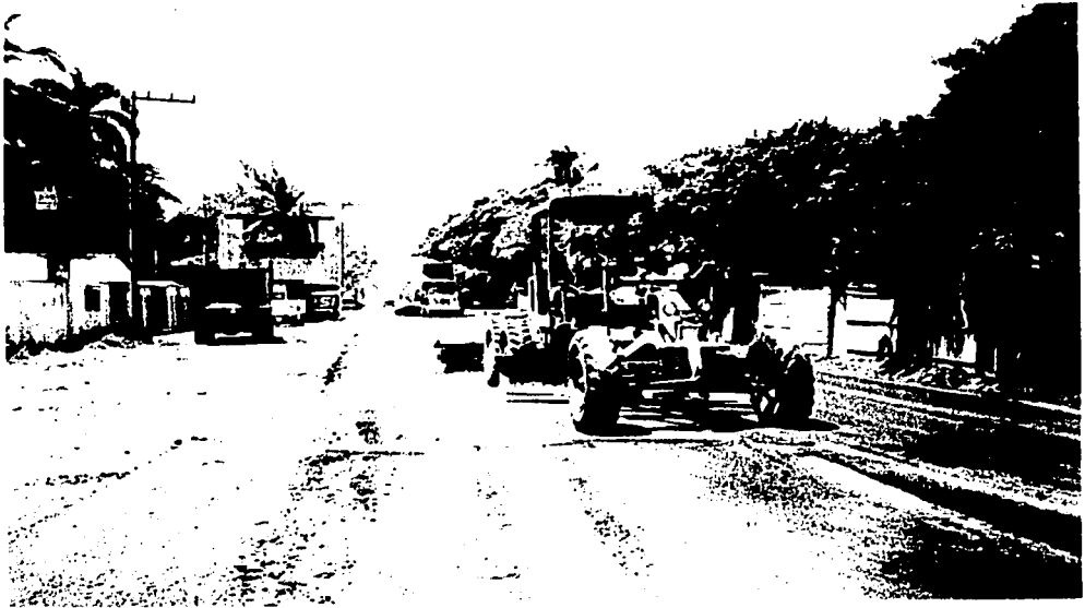
BARRIDO DE SUPERFICIE POR ENCARPETAR.
