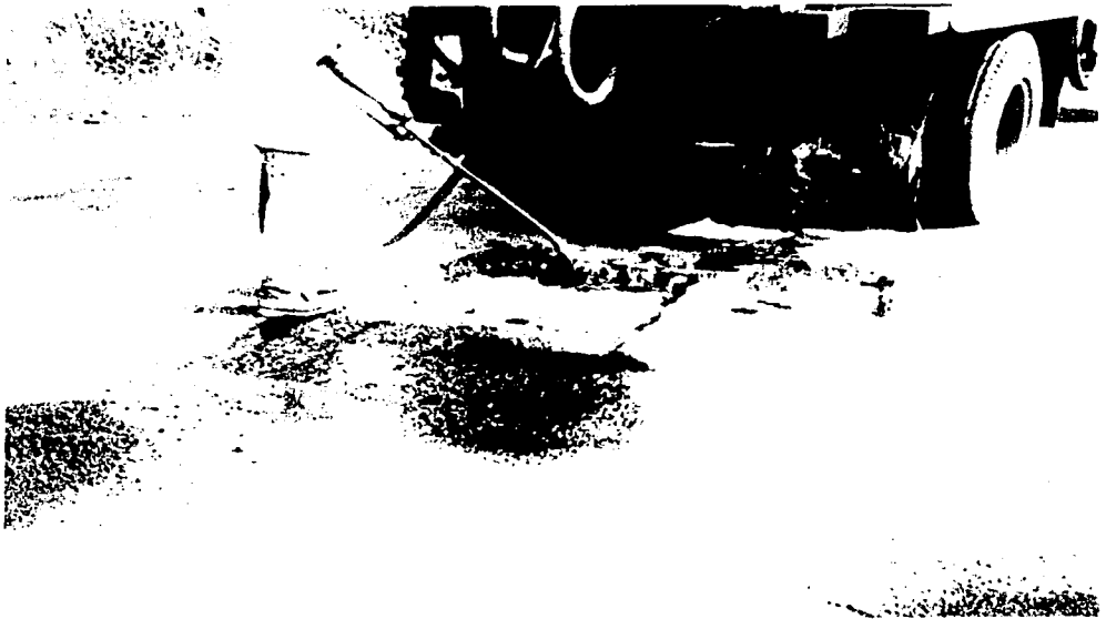
PERSONAL MOJANDO Y LIGANDO LAS CAJAS PARA RECIBIR MATERIAL DE RECARGUE.
