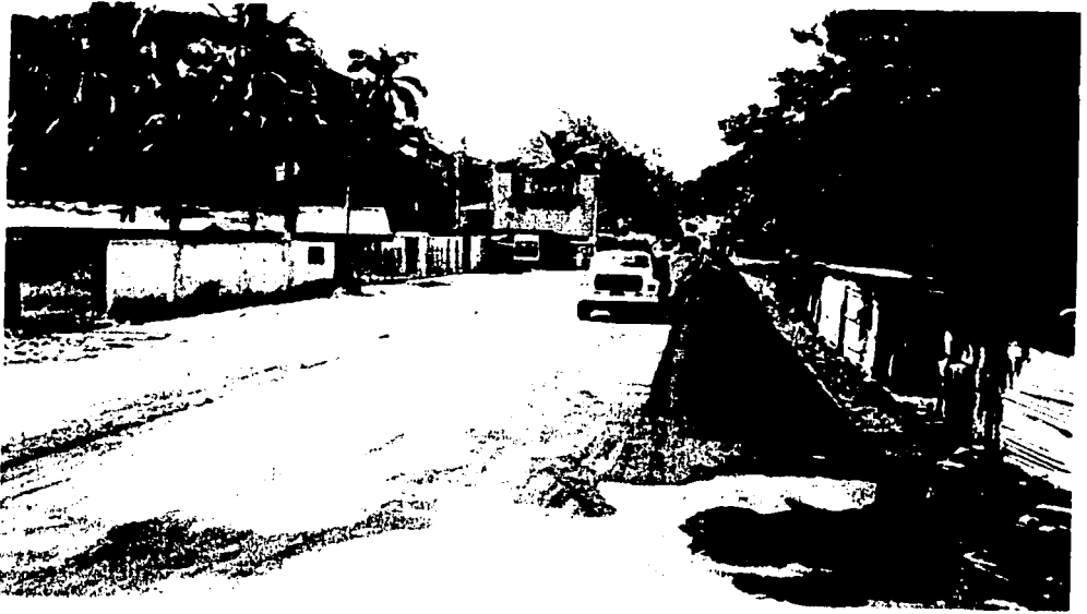
PETROLIZADORA APLICANDO RIEGO DE IMPREGNACIÓN A BASE TERMINADA.
