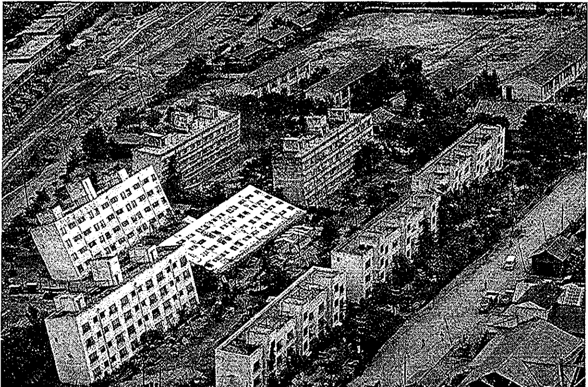
fig. 1.10 Edificios colapsados debido a la drástica reducción de la capacidad de carga
