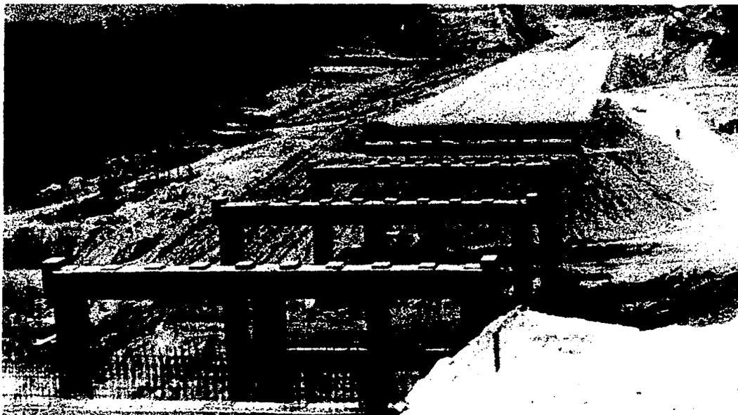
Foto II.7. Formación de un terraplén de acceso a un puente.
