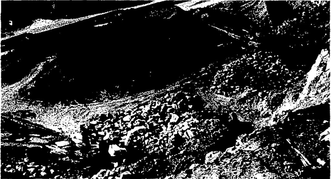
Foto IV.4. Banco de materiales formado en su mayor parte de roca. La retroexcavadora toma el material y lo coloca en la trituradora.
