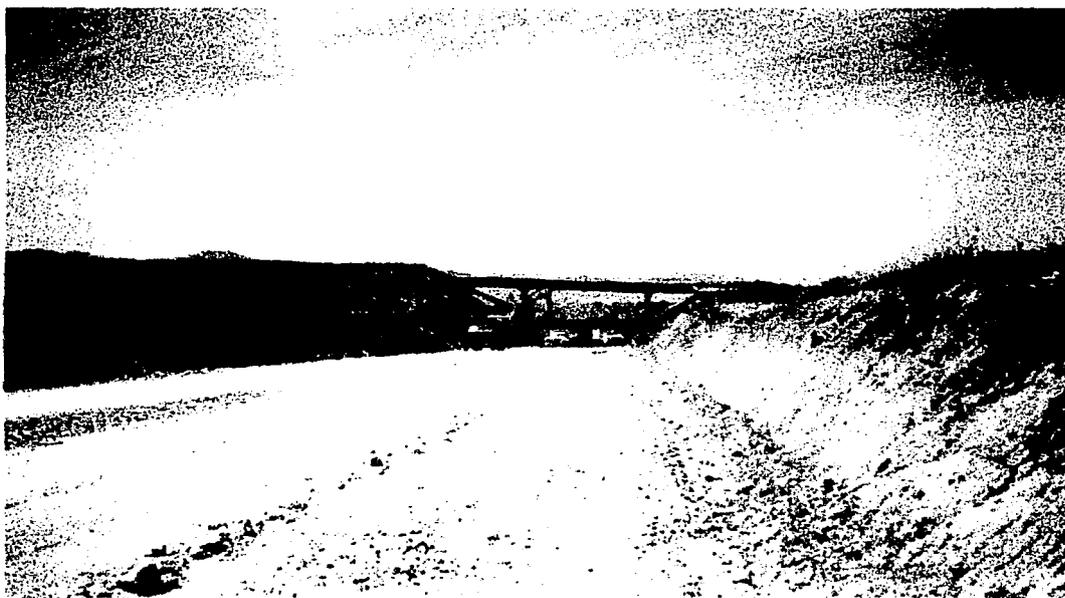
Foto II.6. Excavación de un corte en cajón.
