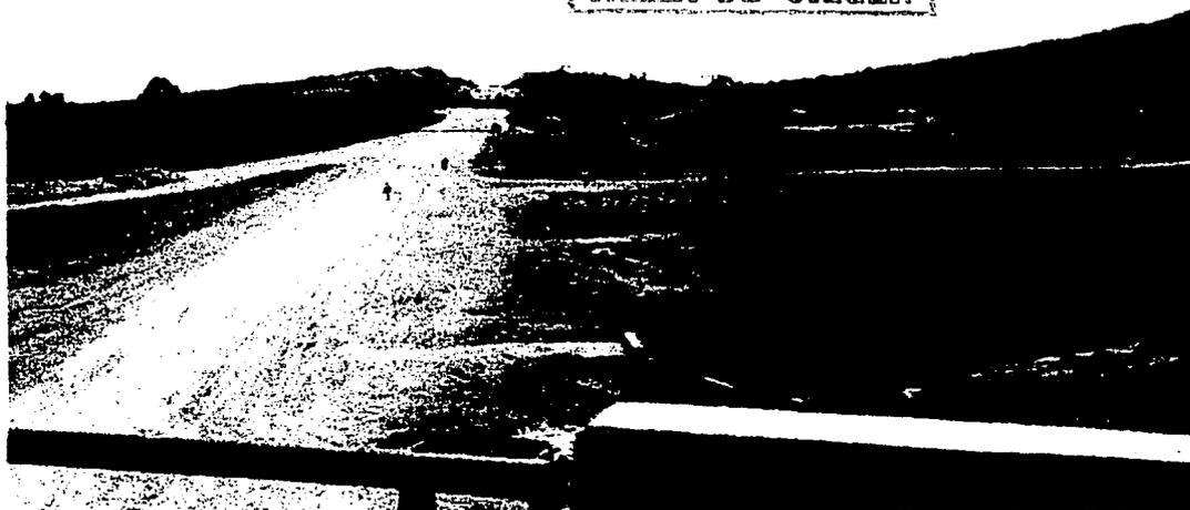
Foto Il.11. Terminación de los trabajos de terracerías.
