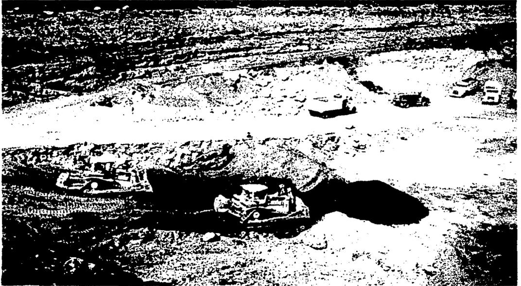
Foto IV.2. Banco de materiales donde se observan los estratos de suelos, los vehículos de acarreo y la forma de trabajo con tractores.
