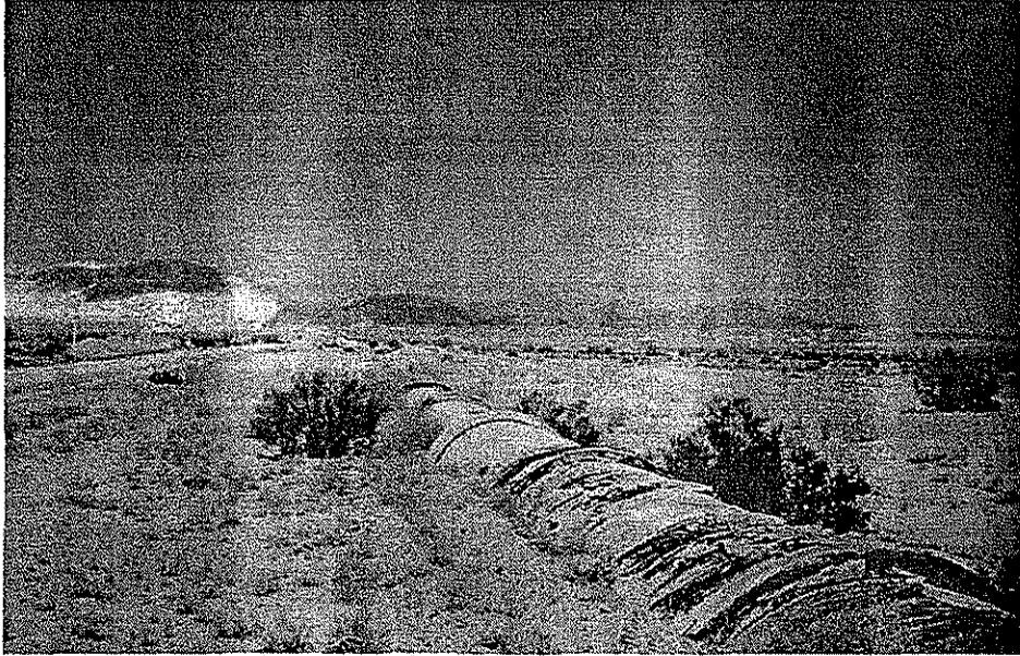
*Foto 1.4. Acueducto Río Colorado – Tijuana, tubería de concreto corroída*
