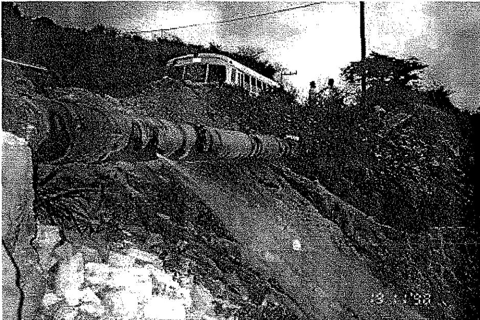
*Foto 1.5. Acueducto Papagayo - Acapulco, fuga en tubería de acero*
