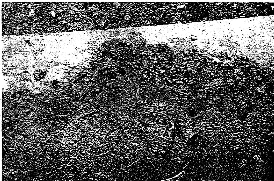
Foto 1.3. Acueducto Estación Manuel - González Tamaulipas, corrosión en tubería de acero
