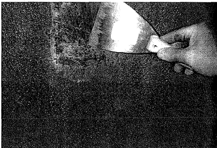
Foto 1.1. Acueducto Chapala – Guadalajara, incrustaciones presentes en el interior de la tubería de concreto preesforzada
