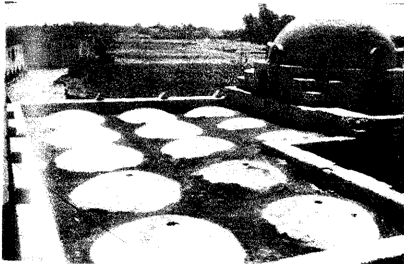
Mezquita del Nuevo Gourna mostrando el techo de la sala de oración con domos contruídos sobre una columnata .
