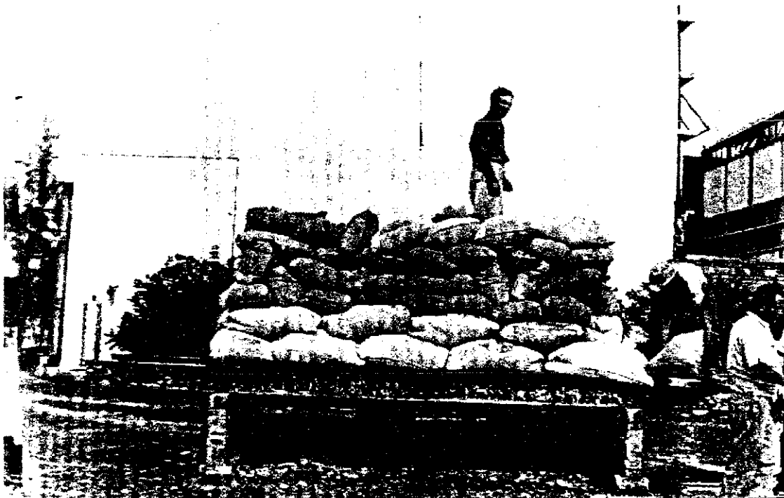
Se lastró la bóveda con bultos de arena. Architecture at Rice University reporte número 18.
