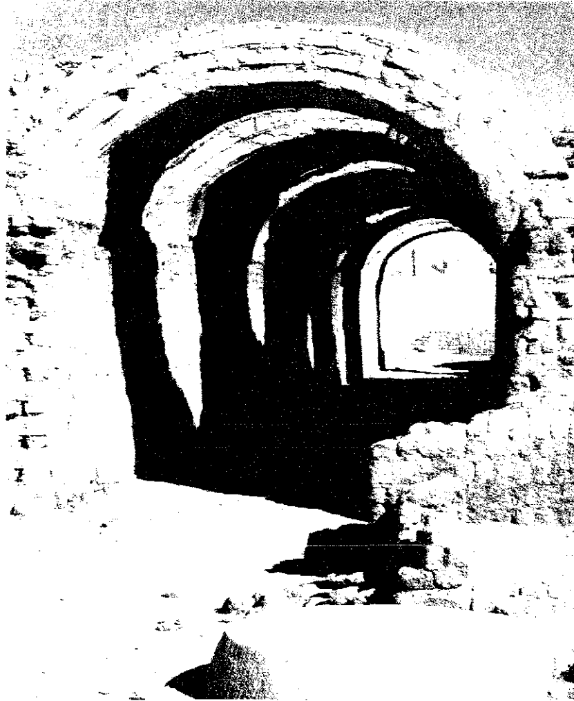
Bóvedas de las bodegas de Ramesseum, primera centuria D C. Fathy se impresionó por la durabilidad y resistencia de los arcos hechos de ladrillos de lodo. Después de casi 2000 años las marcas de los dedos de los albañiles eran visibles todavía sobre los ladrillos.
