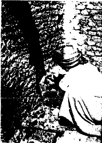
El primer tabique se colocó de punta sobre la pared lateral,... Arquitectura para los pobres, Fathy Hassan láminas 9 y 10
