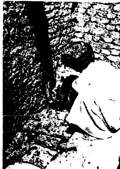
El primer tabique se colocó de punta sobre la pared lateral,... Arquitectura para los pobres, Fathy Hassan láminas 9 y 10
