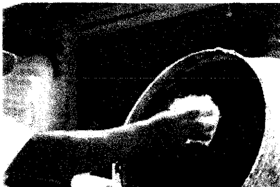
Esta fibra se aplicó con el objeto de evitar posibles cuarteaduras en la cáscara...
