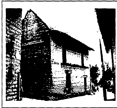
Construcción tradicional de dos niveles sin refuerzos.
