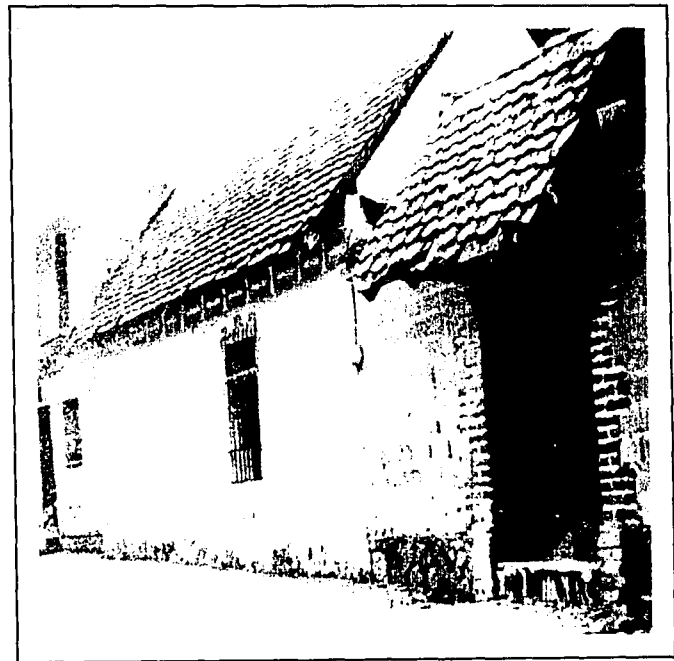
Los tonos ocres de los muros y el café oscuro de las techumbres.
