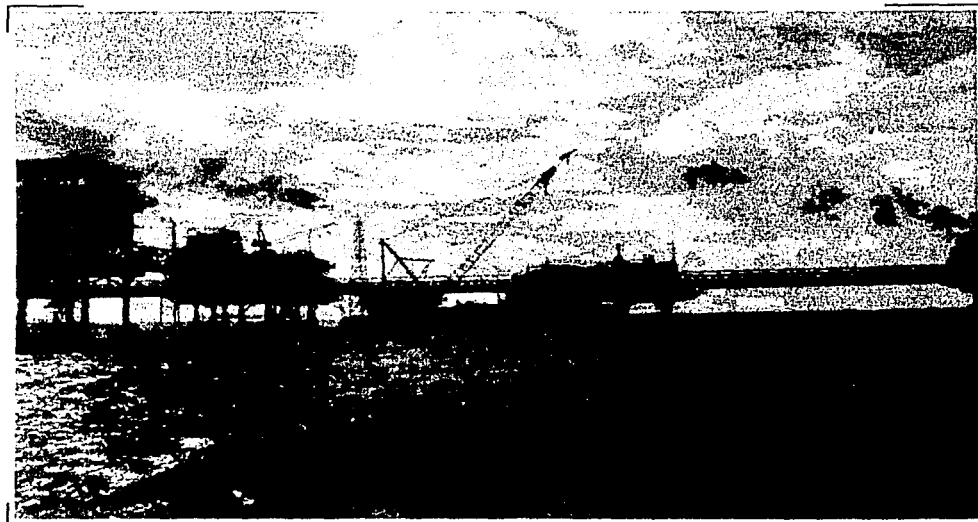
FOTO No. 2 Otra vista del Complejo Akal-J, aquí se puede observar en primera instancia, de lado izquierdo el modulo habitacional. Al frente se observa una barcaza de construcción "acoderada" al Complejo, con la pluma de su grúa desplegada.
