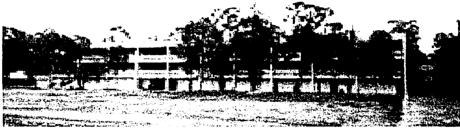
FOTO 5 (anexo fotográfico no. 13)
