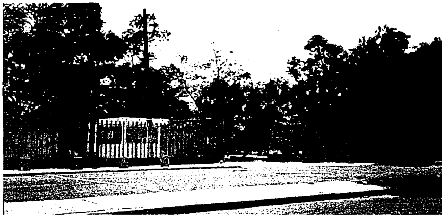
FOTO 3 (anexo fotográfico no. 11)
