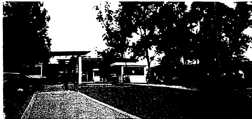
FOTO 4 (anexo fotográfico no. 12)
