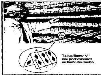
FIGURA I.11 RELLENO TIPO SALPIQUEO DE BARRA V.
