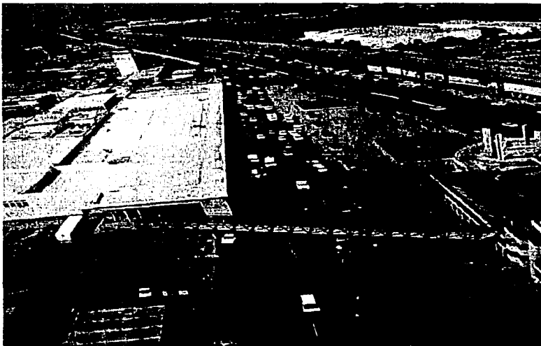
Foto No. 2 Vialidad de Acceso al Aeropuerto, Estacionamiento de Aviación Comercial
