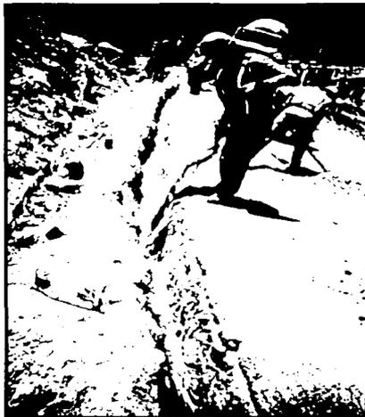
**Foto 4.26 Colocación manual de material fino para evitar erosión.**
