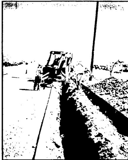
**Foto 4.16** Excavación del ancho del bote de la retroexcavadora.
