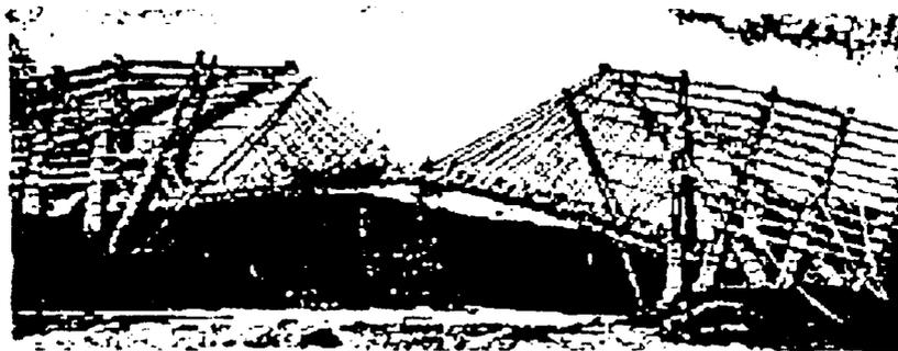
**Figura 2.3** Puente primitivo sobre el río Serajoe en Java, con tirantes de bambú entrelazados con **lianas fijadas** en los extremos con árboles a cada lado. Esta rústica estructura indica que sus constructores tenían una vaga idea de algunos de los principios de la ingeniería estructural de puentes.
