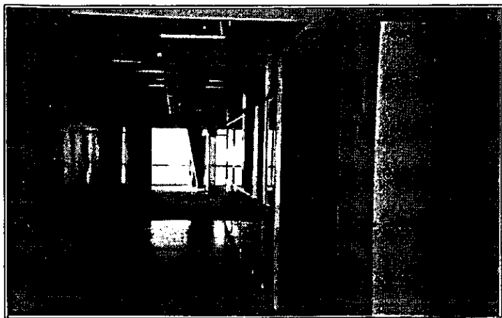
PASILLO INTERNO PISO 18
