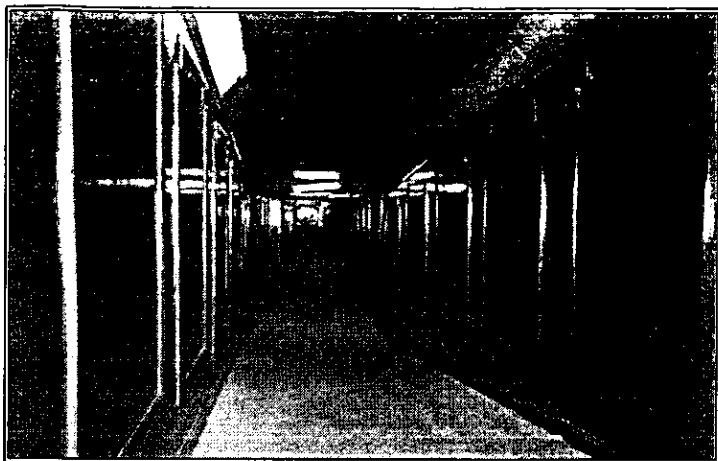
PASILLO EN NIVEL DE SOTANO HACIA ANEXOS (ESTACIONAMIENTO)
