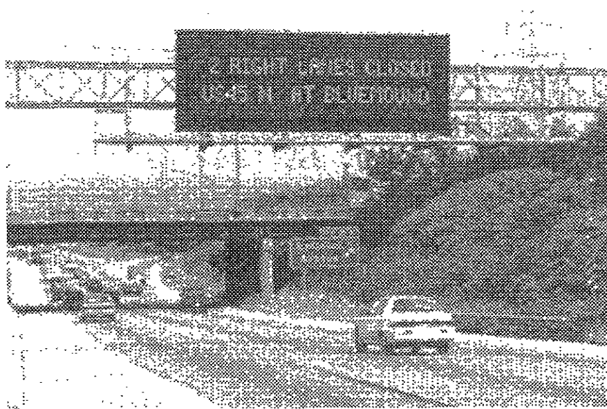
Fig. 6.5 Ejemplo de un señalamiento dinámico en una vía rápida, empleando infraestructura propia para obtener las mejores condiciones de visibilidad según las características geométricas de la vialidad
