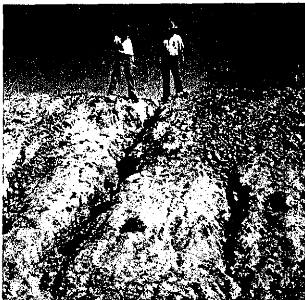
Foto L20: Surcos de erosión en el talud de la cortina.
