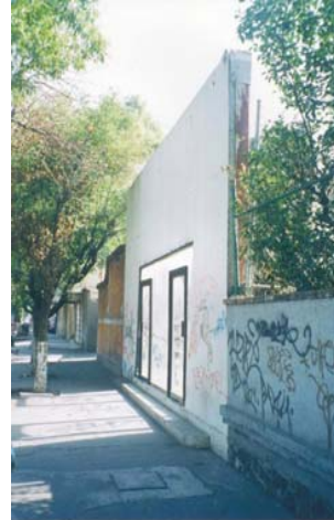
Vista de la fachada, sobre Av. Revolución en dirección NE-SO
