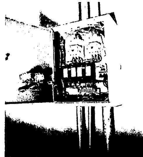
Foto No.63 Tablero de control de reciclaje de agua.
