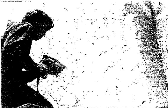
FIG. 90 Realización de una malla de anclaje, para reforzar el aplanado y la imprimatura en un muro de Palmira, Mor. 1995.
