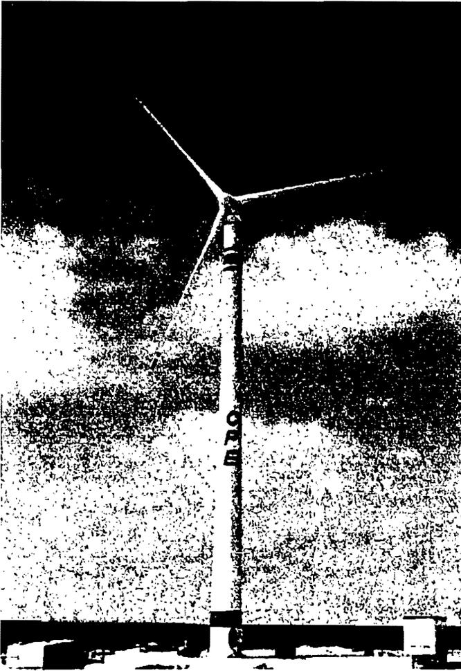
Fig. 4.2. Aerogenerador de 600 kW instalado en Guerrero Negro B.C.S., (CFE).
