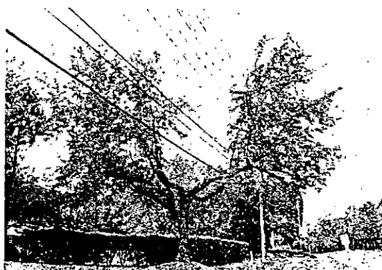
Figura 12. Poda direccional bajo conductores de alta tensión
