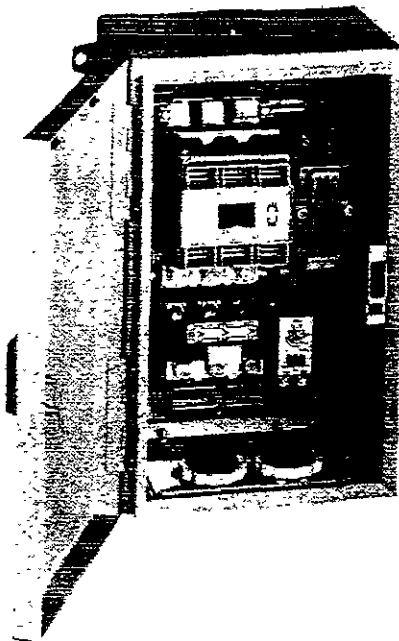
Figura 1.2.3 Protecciones eléctricas de motores (Fusibles).
