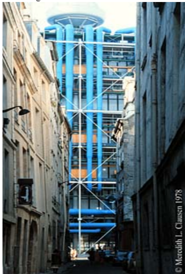
36-Imagen sistemas de instalaciones
