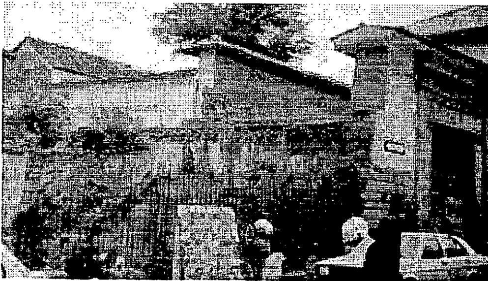
Vista del lado de la calle Afligidos donde se muestra parte de la fachada del objeto de estudio, evidenciando el estado de deterioro y ruinoso. (Fotografía del Autor. 1993)
