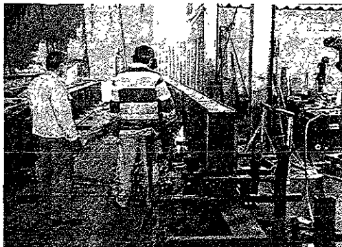
FOTO 3 INSPECCION VISUAL REALIZADA SOBRE LOS ELEMENTOS EN PROCESO DE FABRICACION. EN ESTA SE VERIFICA QUE CADA UNA DE LAS PROPIEDADES GEOMETRICAS ESTABLECIDAS POR PROYECTO SE ENCUENTREN DENTRO DE LAS TOLERANCIAS ADMISIBLES POR LAS NORMAS.
