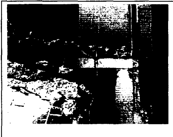
Fig. 7 No consideración de los posibles efectos de torsión en edificaciones de mampostería.
