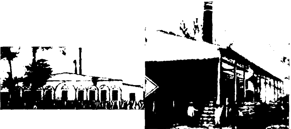
CASA DE MAQUINAS HACIENDA ITZINCAB: FACHADA FRONTAL (IZQ) Y PARTE TRASERA (DER)
