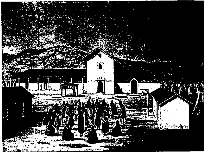
Imagen de la Misión de San Francisco Solano de Oriane Day en la que se aprecia al fondo la vivienda indígena tradicional. HABS, CAL, 49-SONO, 2-5, Library of Congress, Washington
