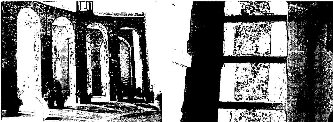
*Foto 5. Columna zunchada, ubicada en la parte posterior del edificio principal del Palacio Nacional, (ref.28)*
