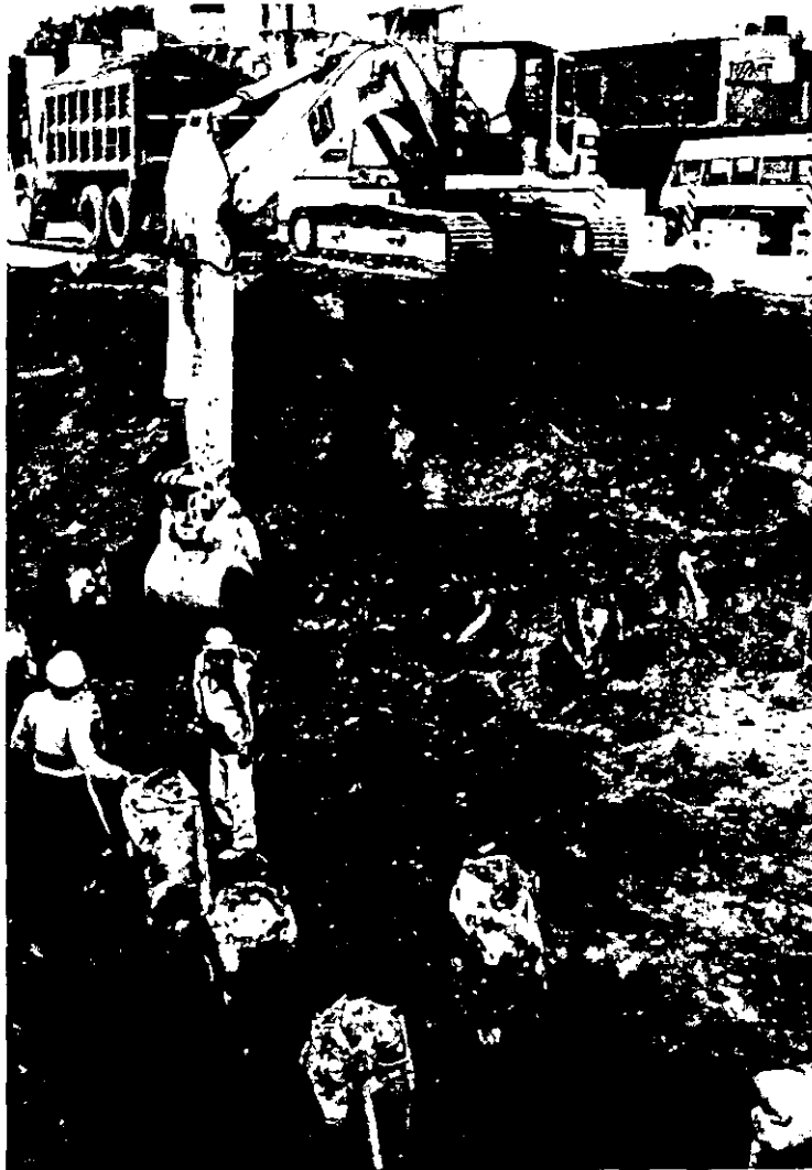
FOTO 4.5. 1. Excavación para zapata
