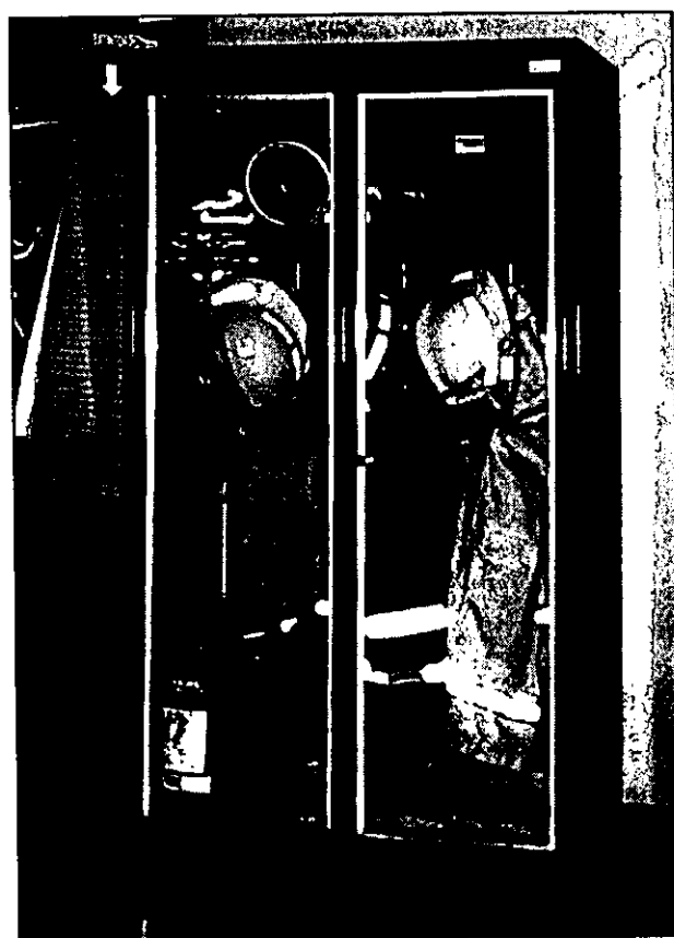
Fig. 40. Gabinete para equipos contra incendio.
