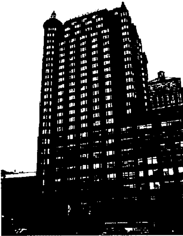
Edificio Hotel Inter-continental.
