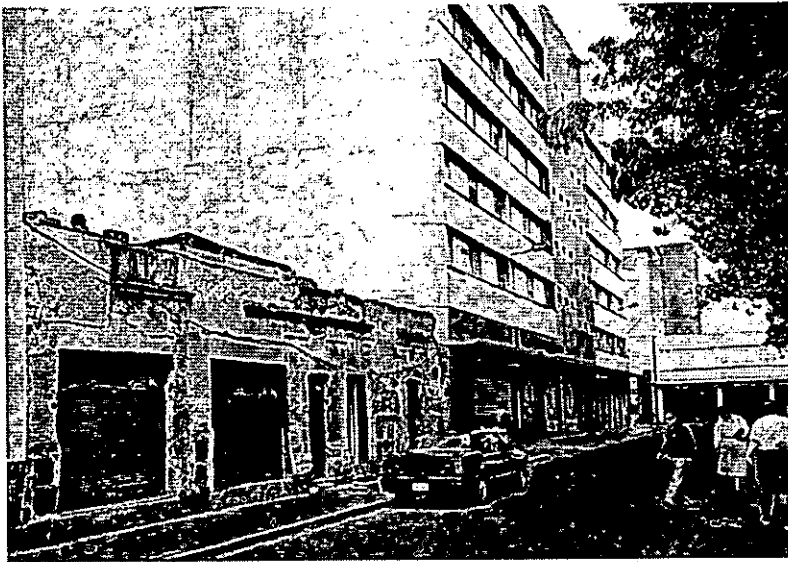
Vivienda deteriorada en la calle de Limón.
