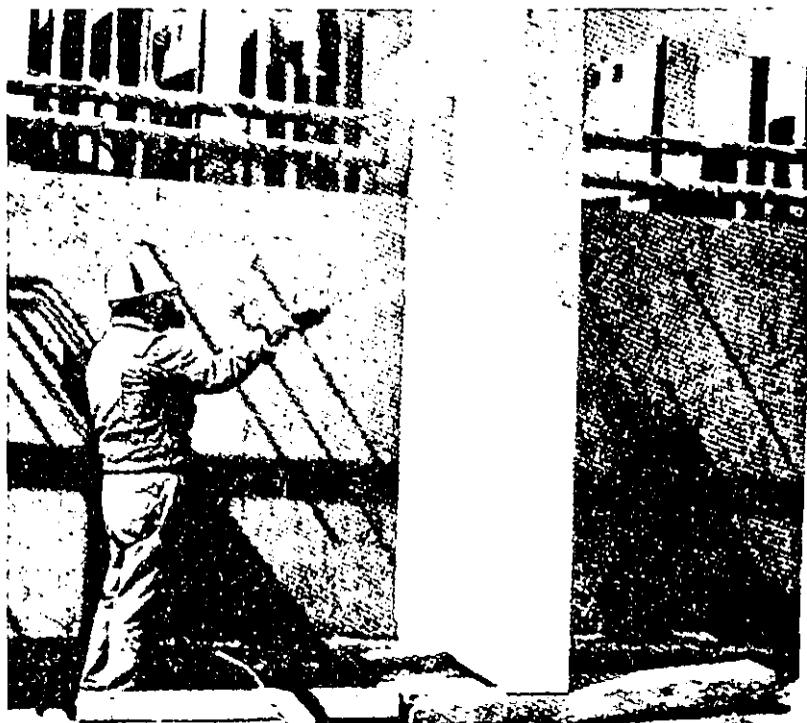
Foto 30. Acabado mediante la aplicación de arena.
