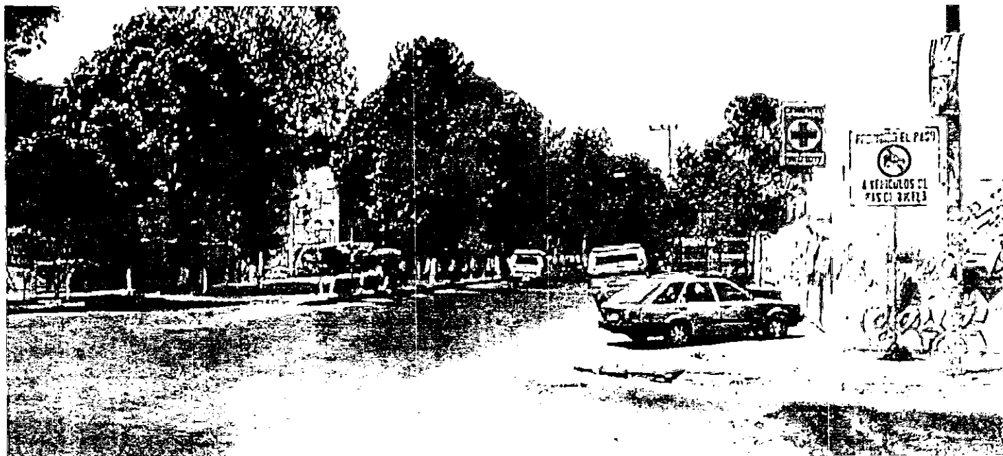
Cruce de la av. Guadalupe I. Ramírez y la calle san Bernardino. Guadalupe I. Ramírez es la otra salida de Xochimilco que conecta con el Periférico.
