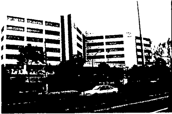
Edificio de oficinas
