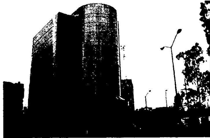
Edificio de oficinas
