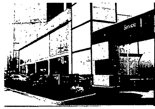
Edificio de automóviles
