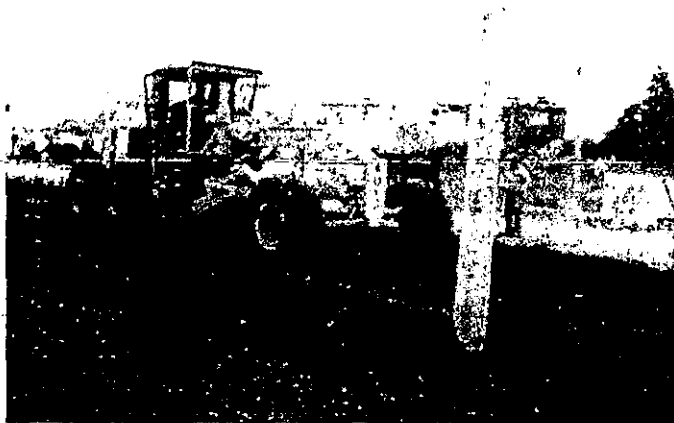
Conformación del material de filtro
