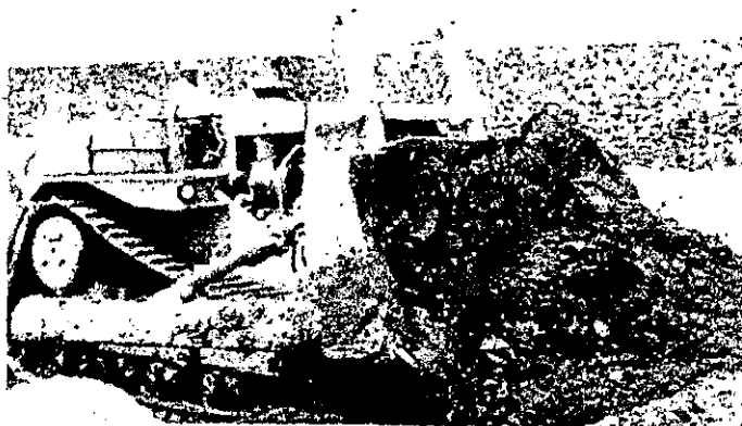
Excavación en caja con tractor D9
