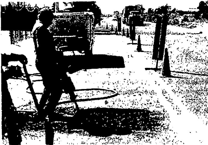
Extracción de la carpeta para efectuar los sondeos en los que se determinaron los espesores y el VRS en el lugar
