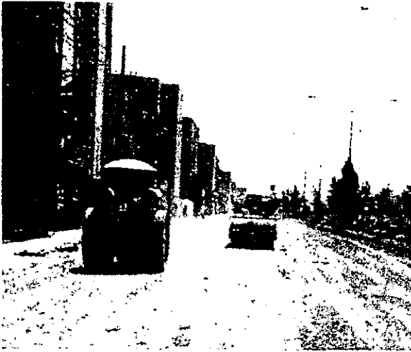
Equipo de compactación en base hidráulica. Rodillos en tandem y triciclo.
