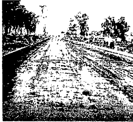
Exposición a la intemperie del riego de impregnación (tiempo mínimo 48 hrs)
