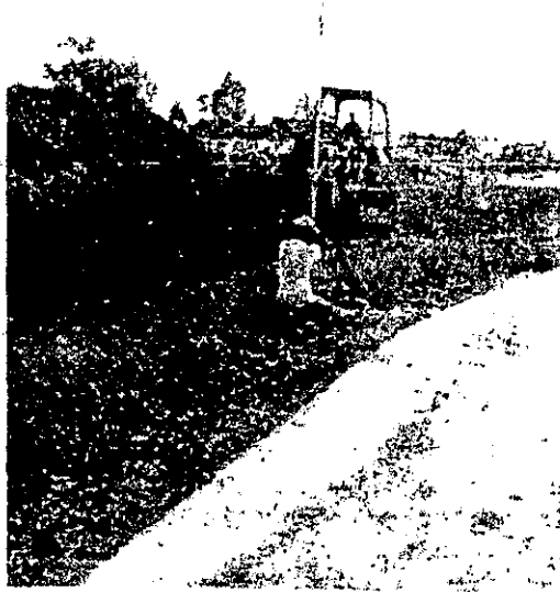
Nivelación de la sección transversal de la vialidad.
