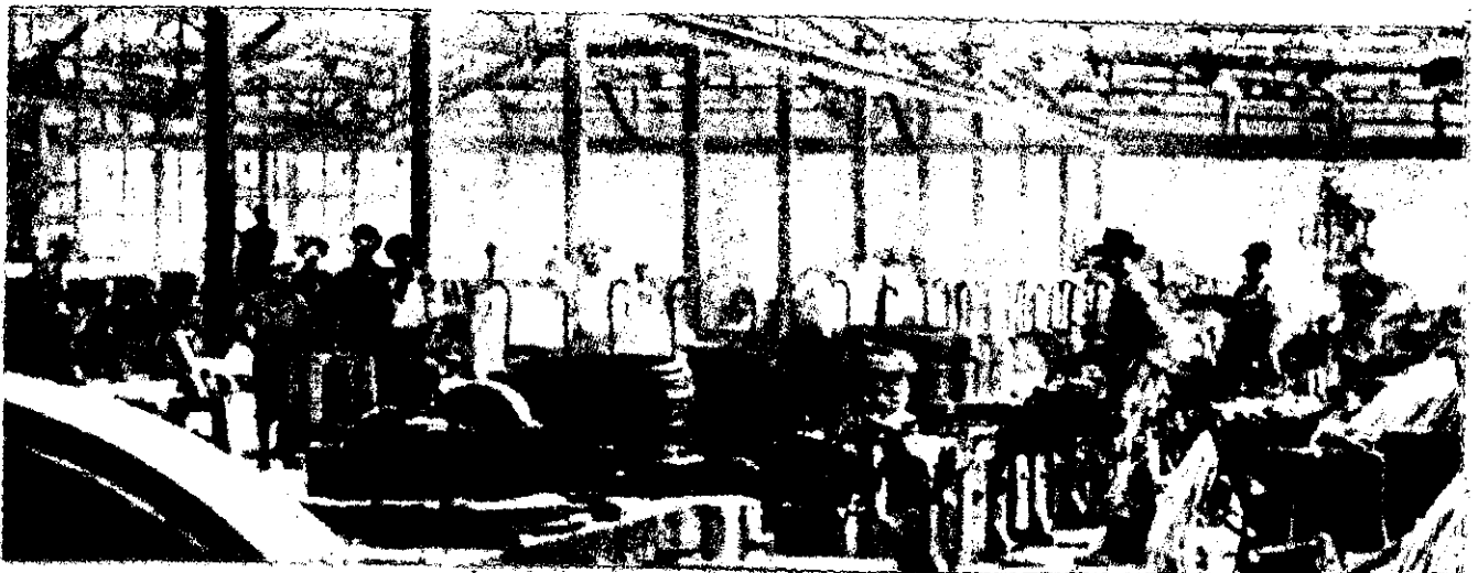
Figura 1-35. Área de estirado de una planta estiradora en 1910, donde los carretes de alambre fueron consecutivamente pulidos, a través de diferentes dados que reducen cada vez más su diámetro.
