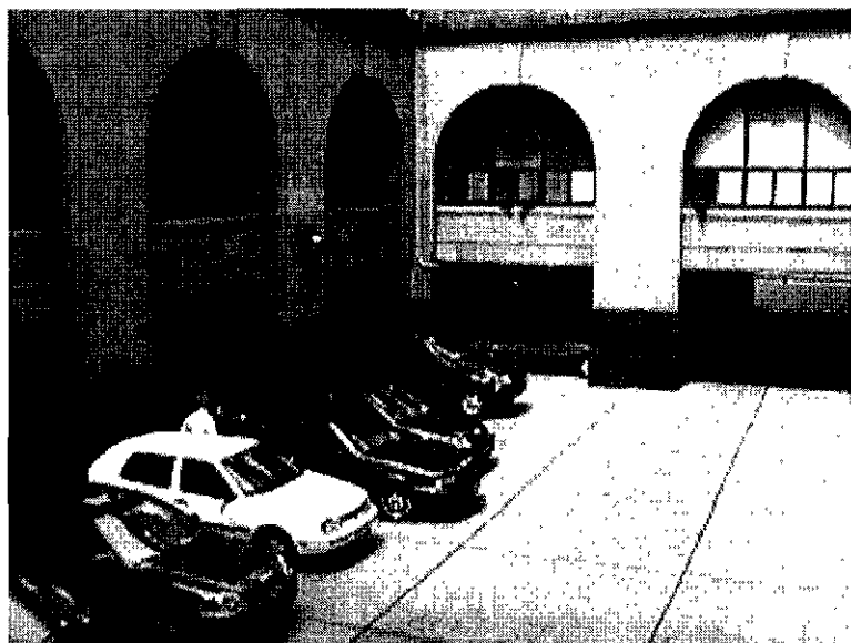
En el sotano del edificio se encuentra el área de estacionamiento, la cual es muy grande
