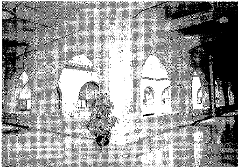
"El edificio está conformado arquitectónicamente por patios interiores, dos principales y dos secundarios, delimitados los primeros por correderos abiertos "
