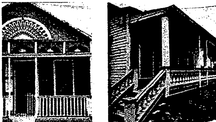
Fotos 10 y 11. Zona de vida Cibao Central. La presencia de galerías es un elemento importante y repetitivo en la arquitectura vernácula dominicana cuyo concepto ha sido trasladado hasta nuestros días. Ciudad de Puerto Plata.
