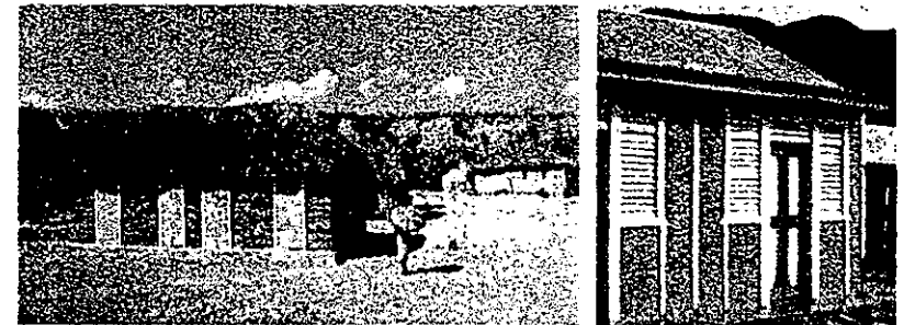
Fotos 6 y 7. Viviendas típicas de las Zonas Nor y Suroeste. Los huecos son escasos para evitar que penetre el calor del exterior. Cuando hay ventanas, éstas por lo general se mantienen cerradas durante el día con los mismos fines.
