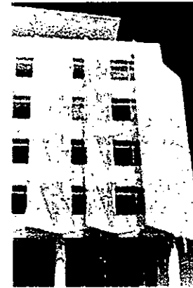
Fotos 13 y 14. Izquierda: Protección solar fabricada con dispositivos transparentes. Se combinan elementos horizontales y declinaciones verticales. Edificio Administrativo Expo Portugal'98. Derecha: Cubierta de techo y persianas horizontales diseñadas para atenuar la incidencia solar.
