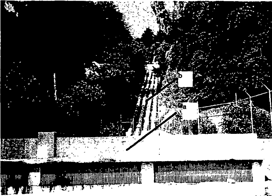
Foto 3 a)Caja rompedora de presión para salvar desnivel y b) by-pass en "San Bartolito".
