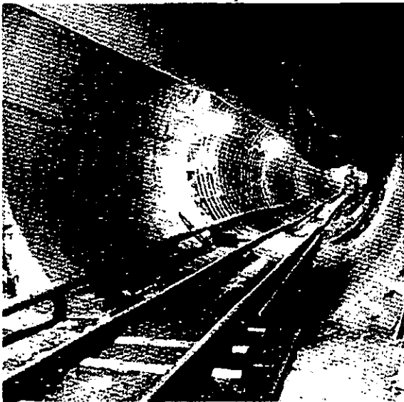
Figura 2.13 Túnel excavado con el Topo
