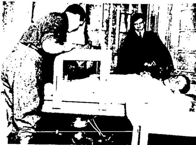
**Fig. 1.** Método de Sutton para la localización por fluroscopia directa de granadas de metralla durante la primera Guerra Mundial en un hospital Americano de Campo (1917).
