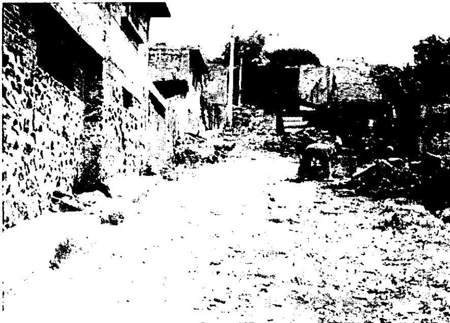
FOTO 5. EJEMPLO DE ALGUNAS CALLES QUE CARECEN DEL SERVICIO DE DRENAJE.
