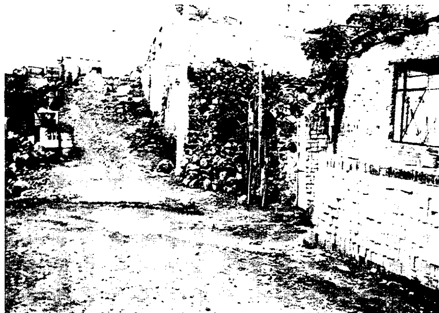
FOTO 7. ASPECTOS DEL SERVICIO DE PAVIMENTACIÓN EN ALGUNAS ZONAS.
