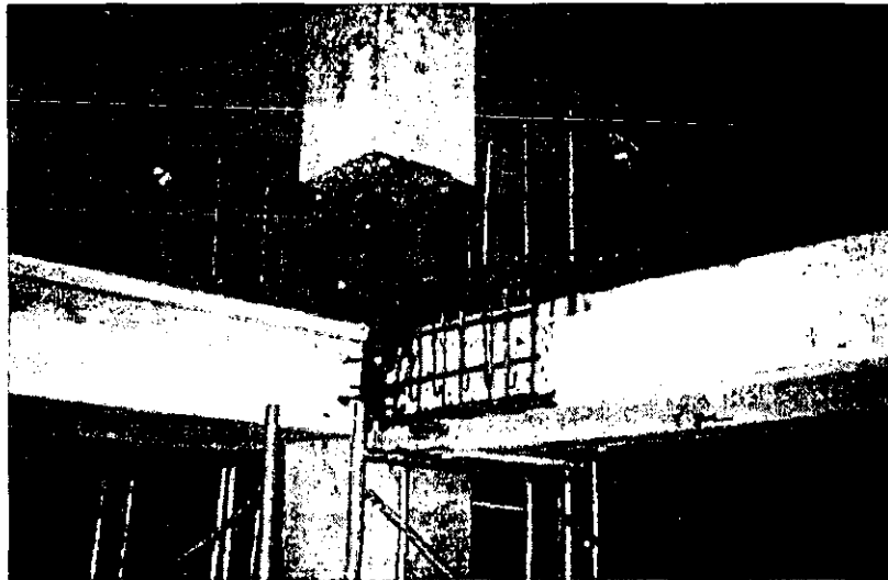
Figura 4.34 – Armado final de la conexión, Modelo J-AP
