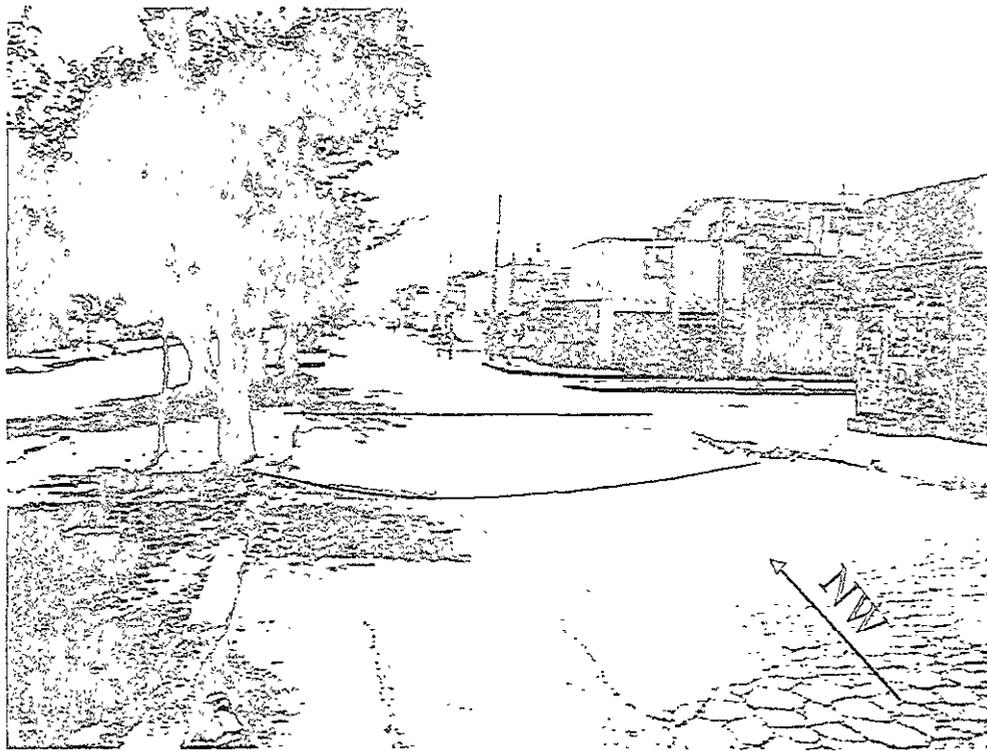
Figura 7.7. – Avenida Exploradores Ejercito de Oriente. Se marcan dos fracturas superficiales; nótese el hundimiento que se muestra en la guarnición.
