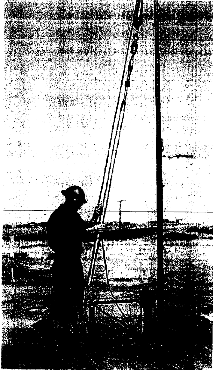
Fig. 1.23 Introducción de una bomba libre mediante cable de acero.
