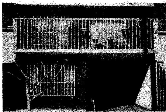
Fotografía 48. Ampliación de una vivienda de una a dos plantas.
