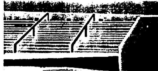
Barandales y escalones
