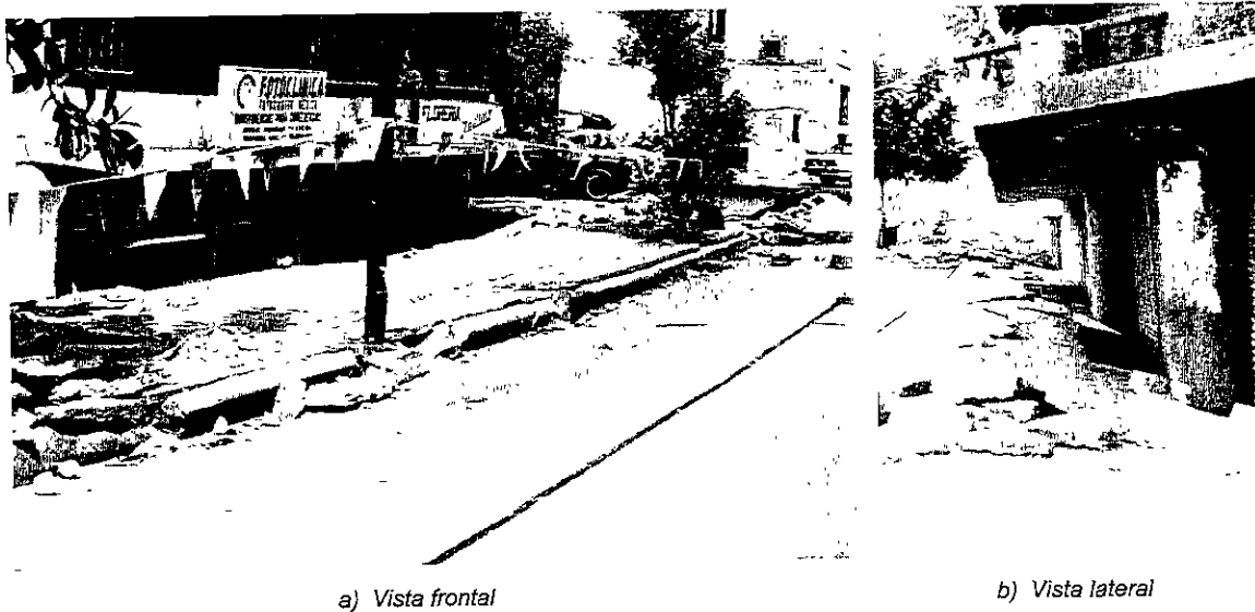
Figura 1.2 Falla de la cimentación de un edificio en Ciudad de México en el sismo del 19 de septiembre de 1985. (cortesía de Miguel Romo y Gabriel Auvinet)
